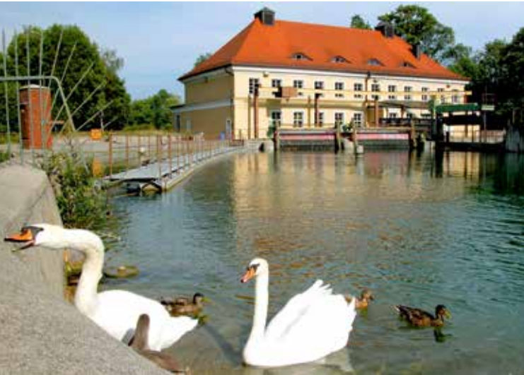
Wasserkraftwerk Isar 3 in Oberföhring.
